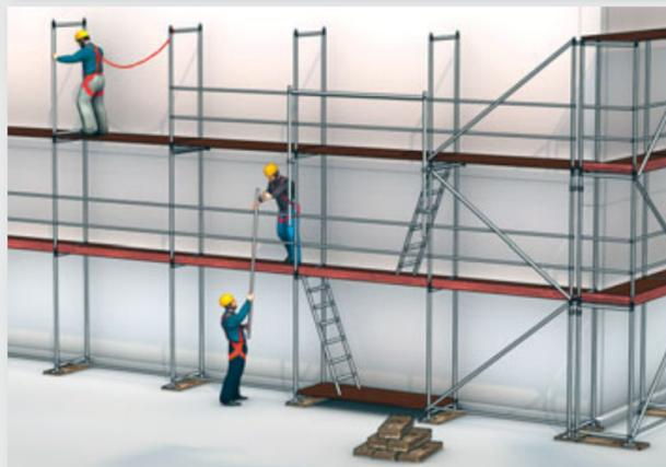
Auf den obersten Lagen arbeiten wir weiter mit Montagesicherheitsgeländer oder speziellem Auffanggurt für den Gerüstbau.
