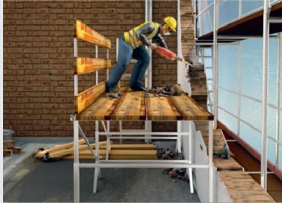
Abbrucharbeiten von geeigneten und gegen Absturz gesicherten Arbeitsplätzen ausführen.
